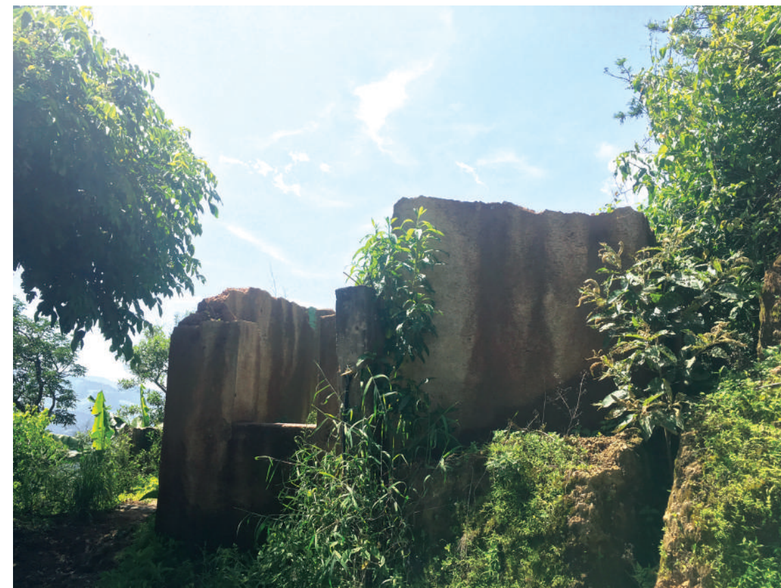
| Fotografía 6: Casa destruida, La Cuchilla
