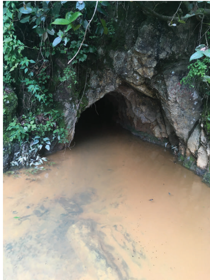
Fotografía 2: Drenaje ácido Mina Mercedes y Santiago
